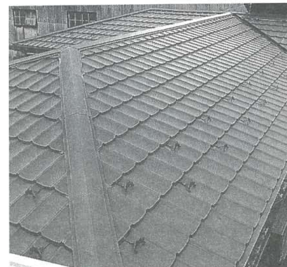
ミリオンルーフトップ施工例（改修）
